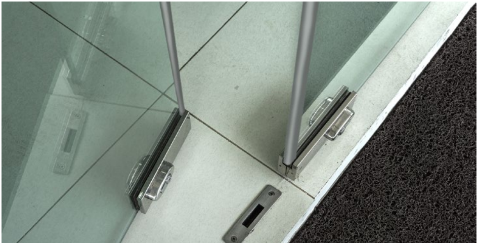
Abb. 6 Kantenschutz für den bodennahen Bereich
